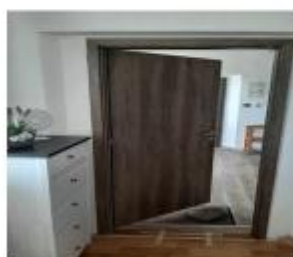
Nové vstupné protipožiarne dvere na každú SUS
